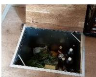
Ein «Naturkühlschrank» befindet sich im Boden. Dieser besteht aus einer Edelstahlwanne. Der Zugang befindet sich unter der Klappe hinter der Türe zur Wohnküche.
